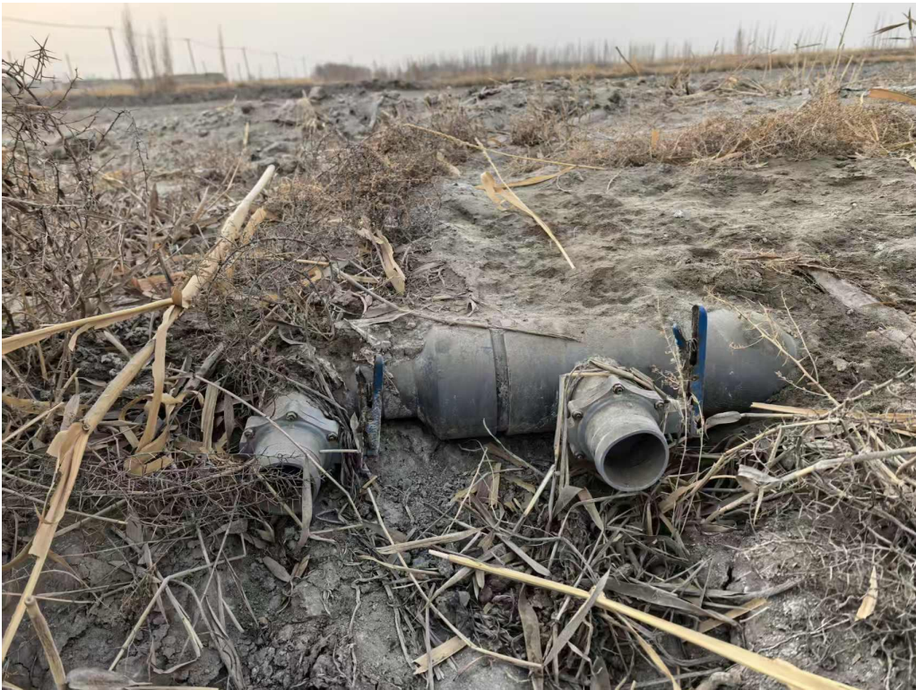
照片 1-1 半埋管道出水口
